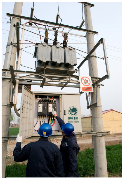
4 月 2 日抗旱保春灌供电服务队，对辖区水利线路、变压器和机井泵房电气设备进行检修维护
